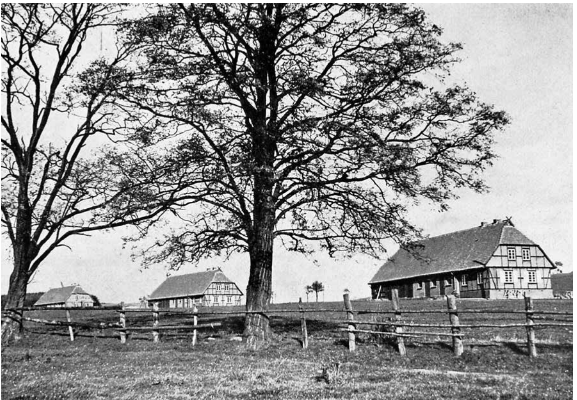
Abb. 2 Karl Witte: Neue Bauernhöfe in Kleinplasten, 1936.
