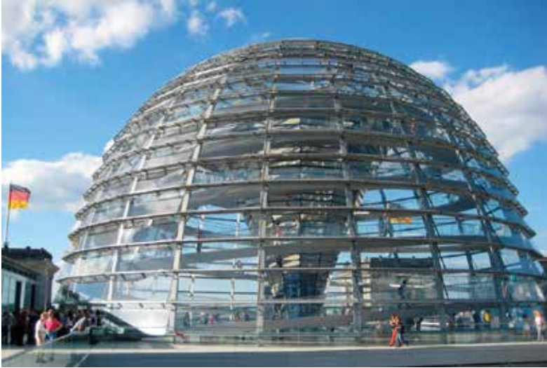
Abb. 7: Die von Norman Foster errichtete »demokratische« Kuppel (1999) auf dem Reichstagsgebäude in Berlin
