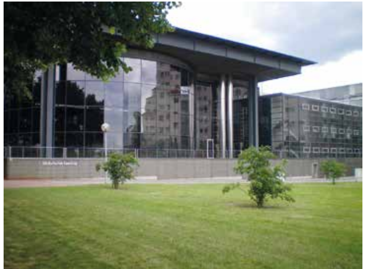
Abb. 5: »Demokratische Architektur« in den neuen Bundesländern. Der Sächsische Landtag in Dresden (1994) von Peter Kulka
